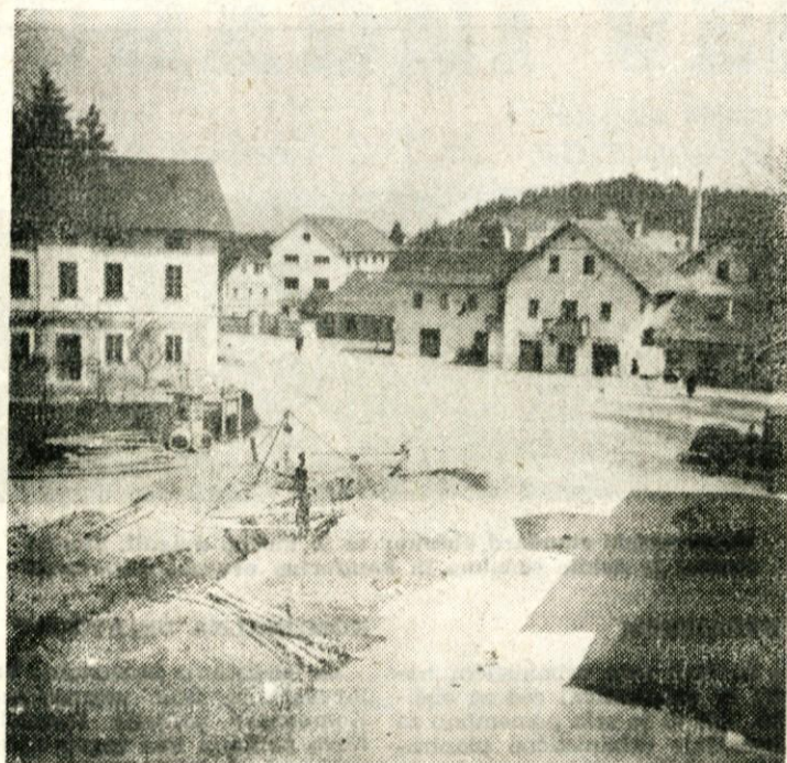
Takole je ob času gradnje kanalizacije in vodovoda izgledalo središče Domžal
