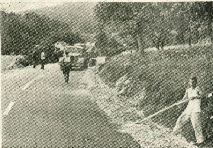
Delavci opravljajo na cesti samo še olepševalna dela
