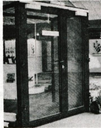
Zasteklena vrata požarne odpornosti.
