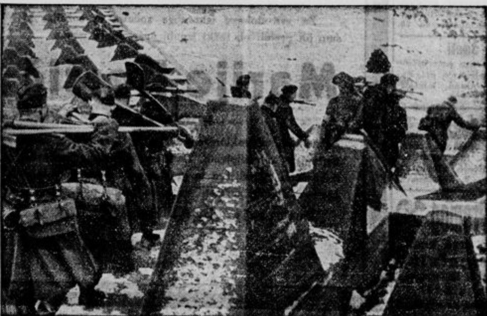
Tukaj korakajo nemški vojaki s logato in krampom mimo betonskih utrd in ovir na čelo v strelsko jarko
