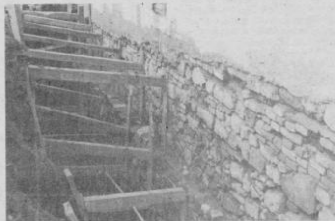
Odpiranje drenažnega jarka na zahodni stranici žitnice, pomladi 1982.
