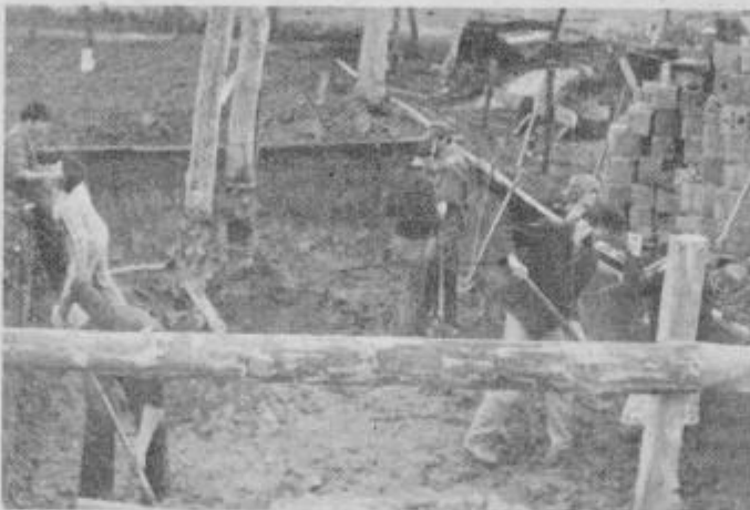
Mladina Sestrž pri lokalni delovni akciji — izkop jame
