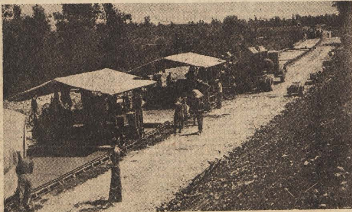
Gradnja avtomobilske ceste Ljubljana-Zagreb tudi v avgustu hitro napreduje. Finišerji dan za dnem dokončujejo na stotine metrov ceste z izgotavljanjem betonske plošče na trdni podlagi, ki so jo zgradile marljive mladinske delovne brigade
