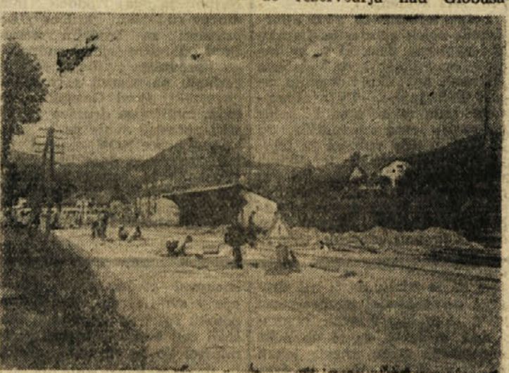
Zaključna dela na cesti pred Trgom revolucije
