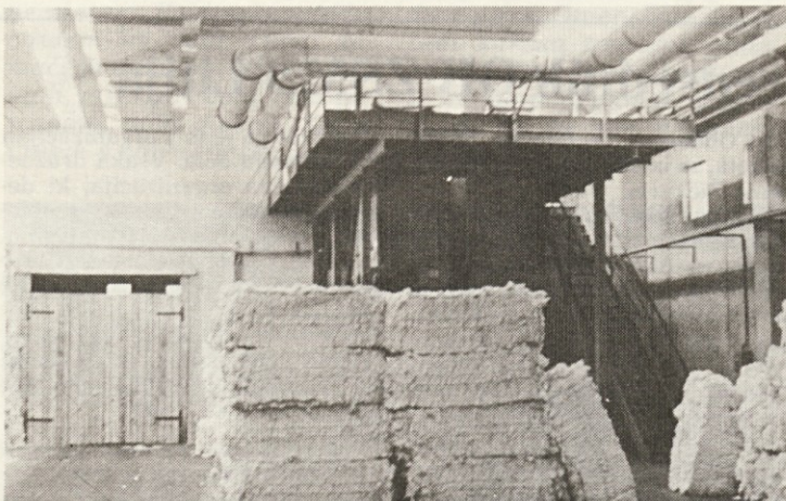
Stiskalnica odpadkov LTG. Nad njo so montirani trije kompaktorji vlaken v katere ločeno dovajajo že očiščene odpadke in izčeske česalnih strojev. V bale stisnjen material se vrne v proizvodni proces.
