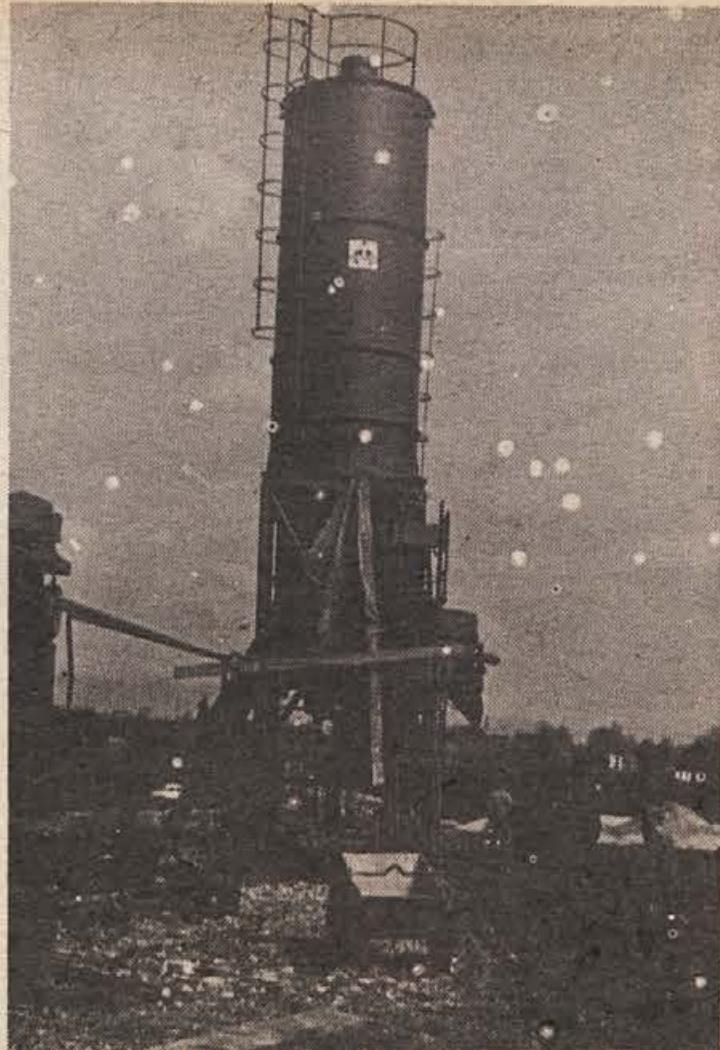
Pred dnevi je steklo delo v betonarni Gradisa ob Savi nasproti Budiča. Vse betonske elemente za novi most bodo zbetonirali na gradbišču (Foto: J. Teppey)
