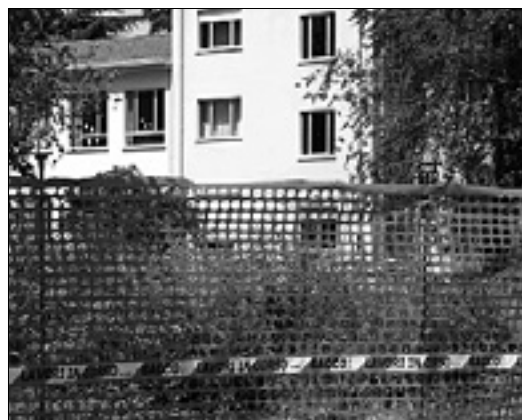
Gradbišče slovenskega šolskega centra BONAVENTURA
