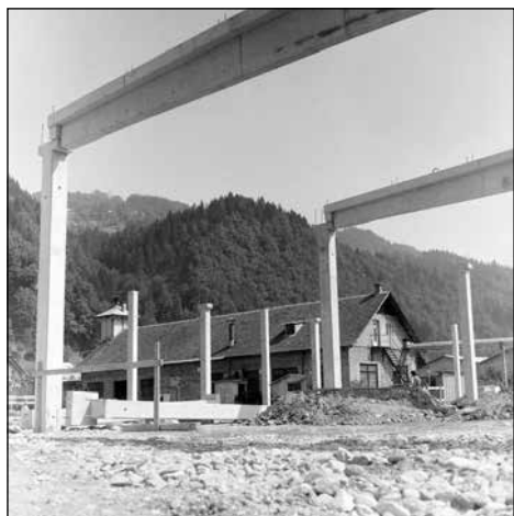
Izgradnja TOZD 3, avgust 1978. Foto: Blaž Dolenc
