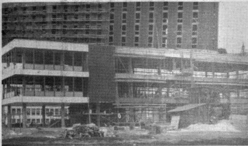
Zgoraj: novi upravni prostor direkcije rudnika lignita; spodaj: prostori poslovnega združenja energo-kemičnega kombinata v Velenju
