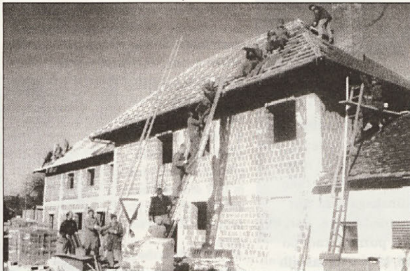
Pri pokrivanju strehe objekta so grabenemu podjetju iz Cerknice priskočili na pomoč številni farani.
