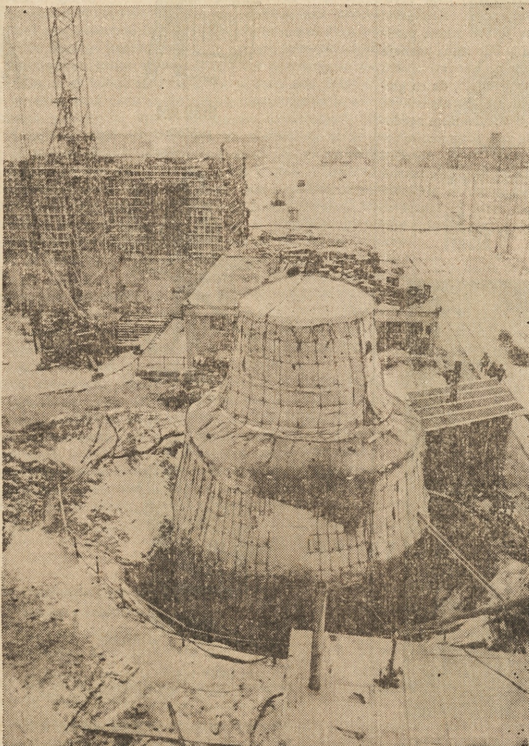
POD VARNO ODEJO — Slika kaže gradnjo prvega atomskega reaktorja na Slovaškem. Zaradi mraza so stavbo v gradnji prekrili s toplimi oblogami, da so lahko v miru delo nadaljevali brez nevarnosti zamrzitve.
