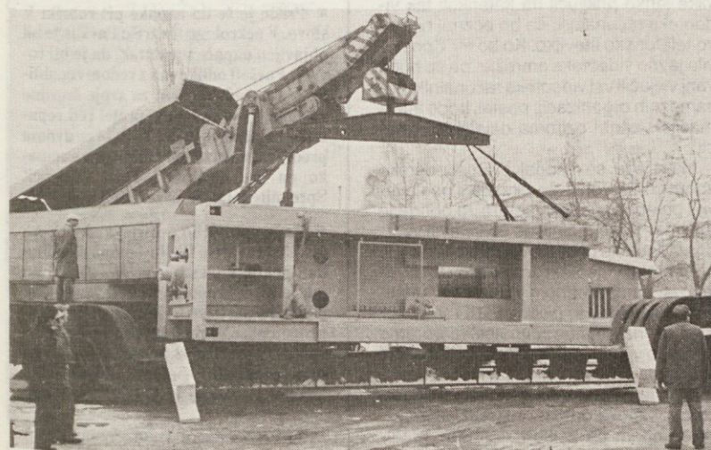
Prpriave za transport preoblikovalnega stroja za Romunijo s pomočjo železniškega dvigala. Preoblikovalni stroj je tehtal 119.500kg in je bil največji, ki smo ga doslej iz tozda PPO odposlali v enem komadu. (Foto: B. Francelj)
