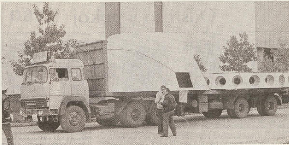
Oprema za VTI Žarkovo naložena na kamion tik preden je bila novembra 1987 odposlana iz Litostroja. Naložena oprema je bila široka 6 metrov — torej širša od samega vozila (Foto: B. Francelj)
