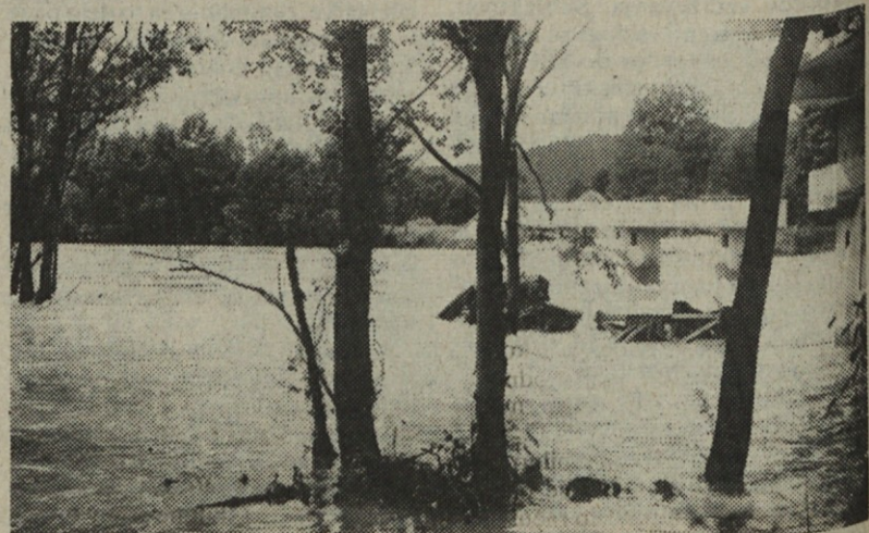
Deroča Sava je v začetku junija odnesla pripravljen nasip in zalila del opreme. V ozadju so nosilci za nov most pri Dolskem nedaleč od Ljubljane
