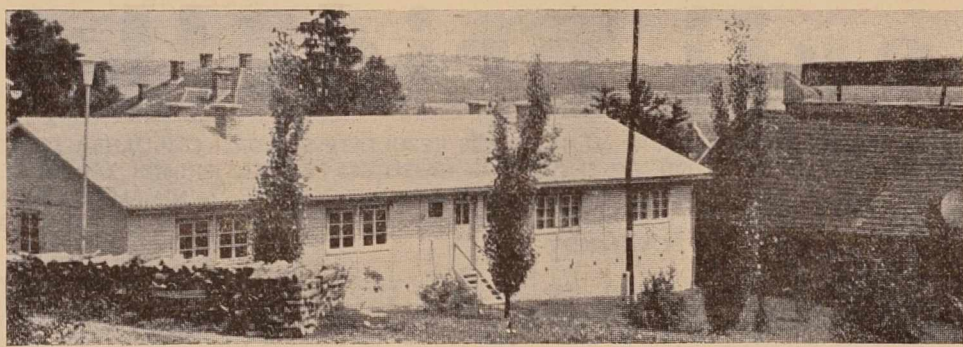
Poslopje elektrifikacijskega centra pri Vidmu
