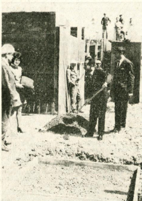
19. aprila je predsednik občinske skupščine Albin Klemenc »zabetoniral« temeljni kamen za novo šolsko poslopje na Rojajah, ki bo že 1. februarja 1972 sprejelo učence pod svojo streho
