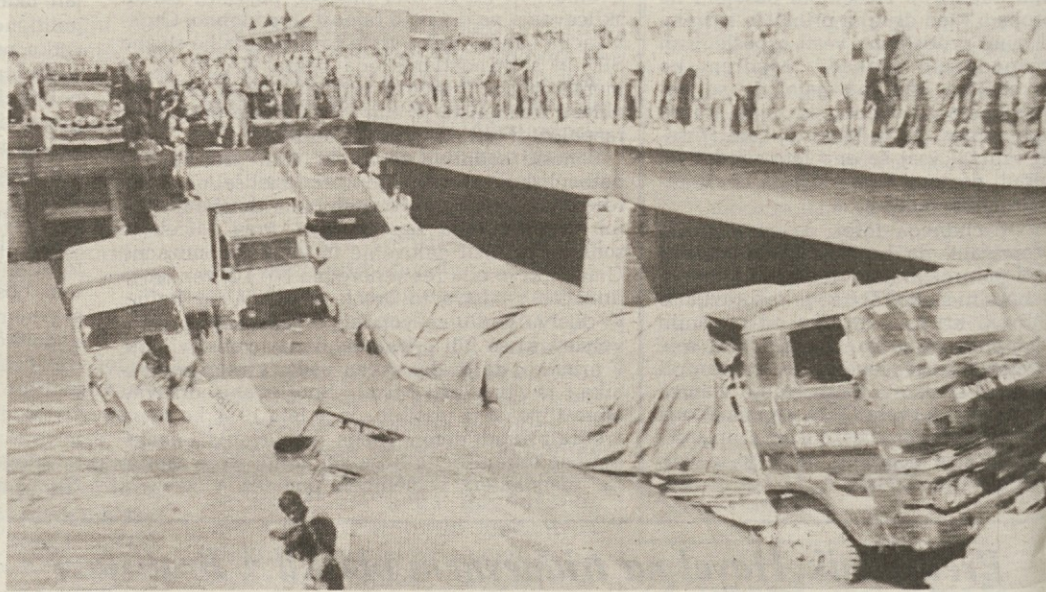
V predmestju Manile se je podrl 50-metrski odsek mosta, po katerem je v trenutku nesreče potekal gost promet. Pri nesreči sta dve posebi utonili, kakih dvajset pa so rešili iz vode (Telefoto AP)
