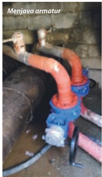
Vzdrževalna dela na cevovodu
