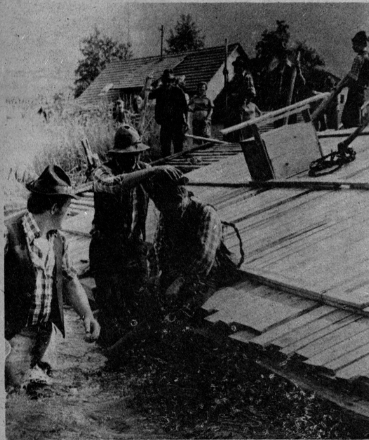
Na Ljubnem so ob udiranju floca opravili tudi potreben „obred“.
