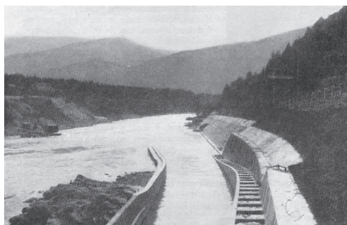
Slika 6: Izliv ribjega prehoda v reko Dravo (Munda, 1928)
