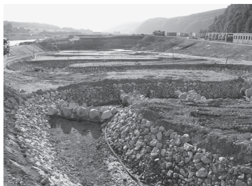
Slika 4: HE Blanca - odsek obtočnega kanala (elementi za uravnavanje dinamike vodnega toka) Fig. 4: Blanca HPP – section of the bypass channel (elements for the regulation of water current dynamics)
