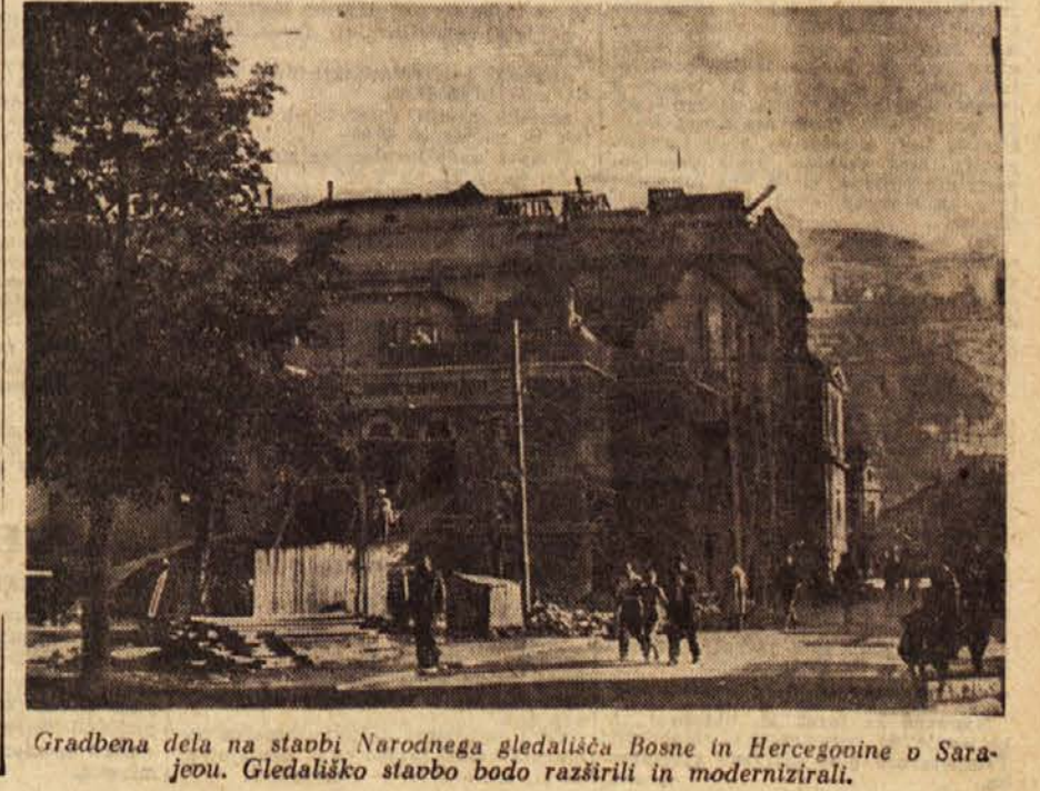
Gradbena dela na stavbi Narodnega gledališča Bosne in Hercegovine v Sarajevu. Gledališko stavbo bodo razširili in modernizirali.
