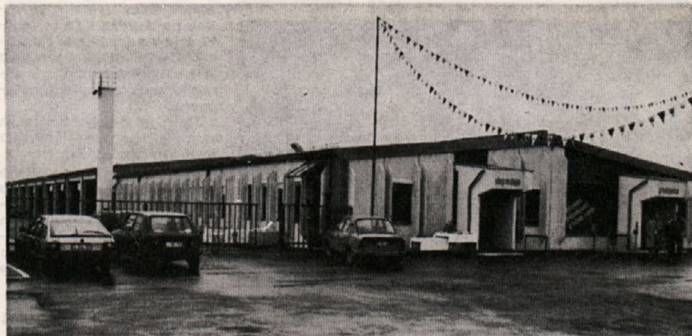
Delavci TOZD Gradbeni operativna Celje so v zadovoljstvo investitorja pravočasno dokončali objekt ERA v Trnovljah. Foto: VIII Šuster
