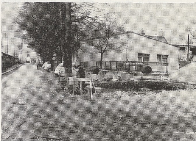
Priprava temeljev za novo vratarnico.
