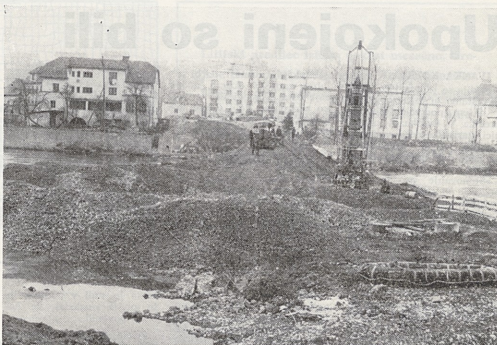
Ena od faz gradnje mostu: vrtanje terena za nosilne stebre.
