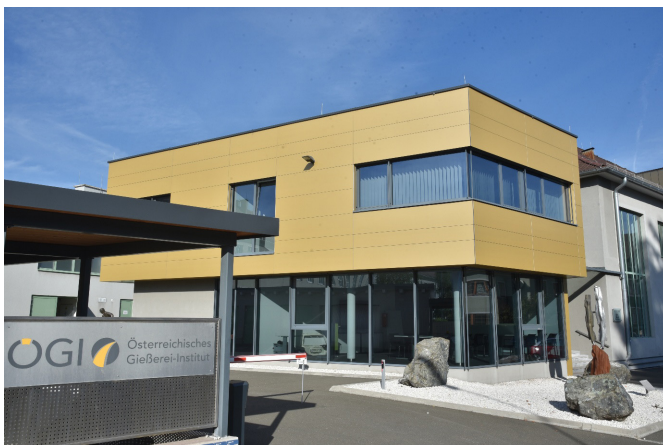
Stavba OGI - Avstrijskega livarskega inštituta v Leobnu
