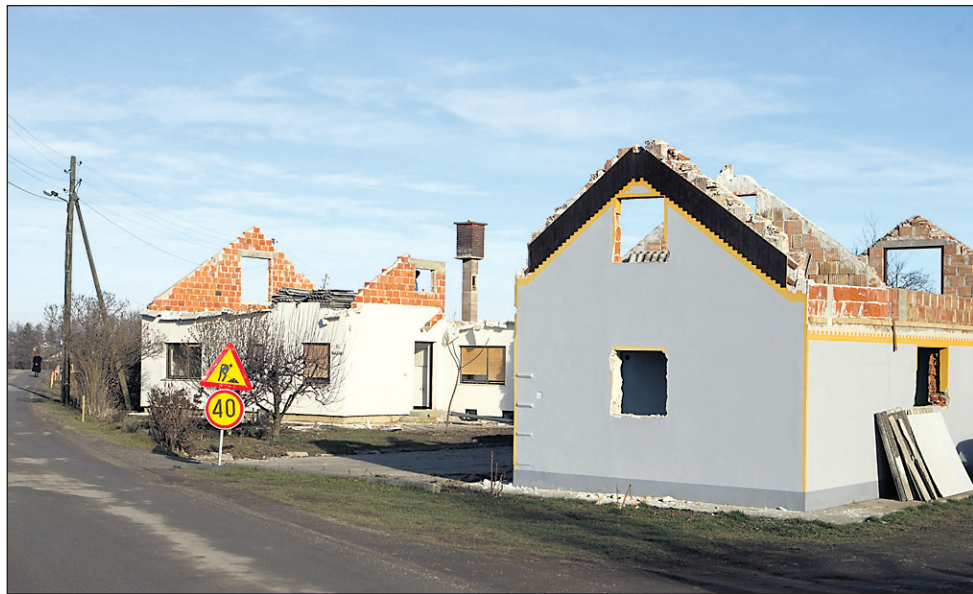
Foto: Črtomir Goznik Septembra se je pričelo prvo rušenje objektov. Na območju občine Hajdina naj bi porušili trinajst stavb, pri čemer so se izvajalci del odločili, da vseh ne bodo porušili takoj, ampak so jih spremenili v svoje delovne prostore.
