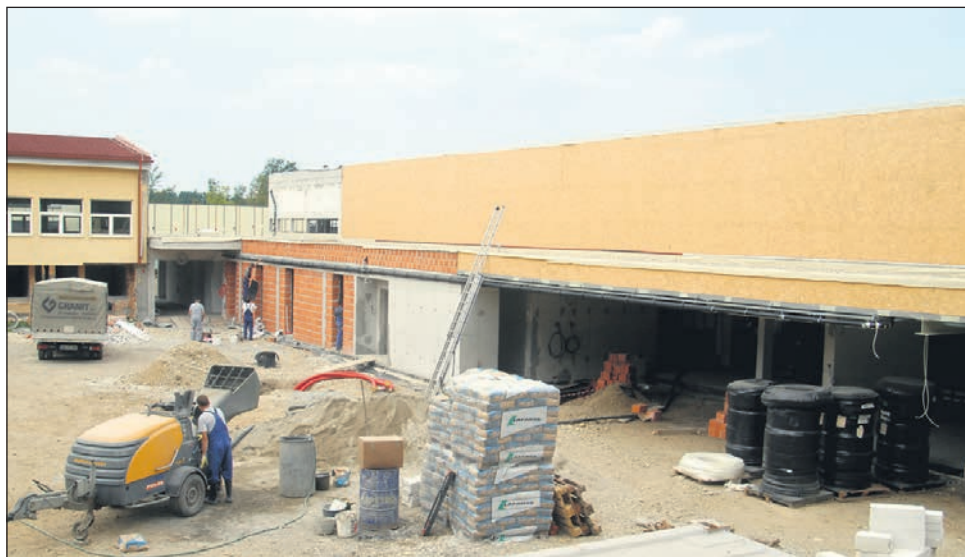
Gradnja nove večnamenske dvorane pri osnovni šoli v Kidričevem je te dni v zaključni fazi.
