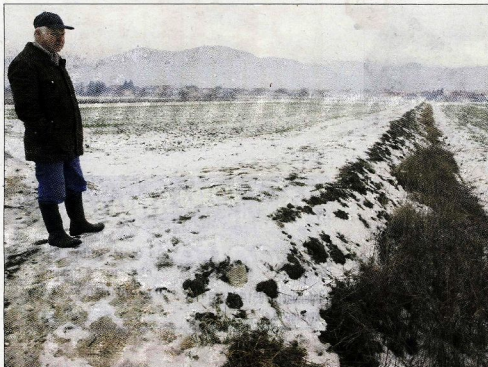
Sanacija protipoplavnega nasipa je razdelila krajano Levca. Gradbenega dovoljenja za nasip (še) ni, krajani pa izčejo zagotovilo za varnost. Na sliki Ivan Peček, lastnik dela zemljišča.
