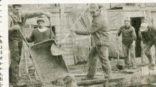
DELAVNI PLANINCI NA KRIŠKI GORI - Zadnji aprilski dan so na prizidku h koči na Kriški gori s prostovoljnim delom zabetonirali ploščo nad pritličjem. Kljub slabemu vremenu so v prazničnih dneh uspeli posidati stene do strehe in spraviti les za ostrešje do koče, nov sneg pa je preprečil uresničitev načrtov za postavitev ostrešja. Več o delu planincev v reportaži na zadnji strani! S. S. - Foto: S. Saje
