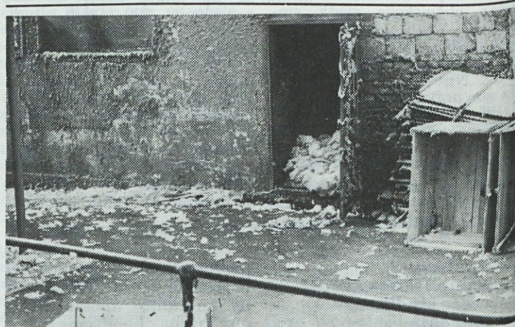
Zaradi nadtlaka v prašni komori, so delavci čistilnice ob pobiranju odpadkov odpirali vrata in tako povzročali onesnažitev dvorišča zabojarne z bombažnimi kosmiči.
