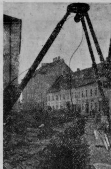
Razkopana ulica in čez jarek postavljena dvigalo za vodovodne cevi je za Ptujčane dokaz, da bo vedno popolnejše vodovodno omrežje v Ptujju kmalu služilo namenu.
