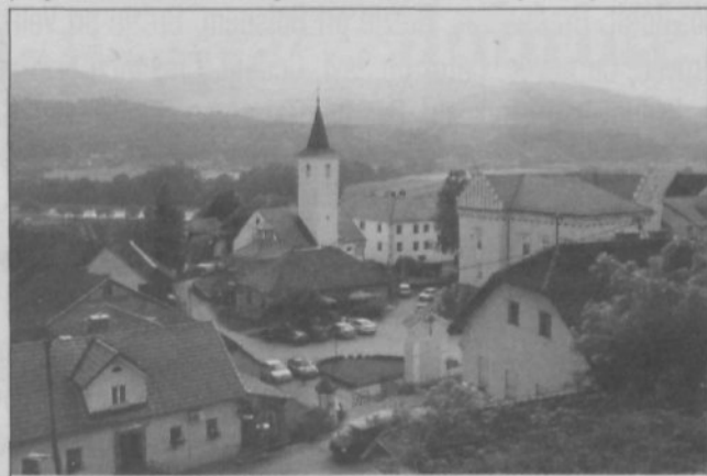
Loka pri Zidanem Mostu (foto: V. Zupančič)
