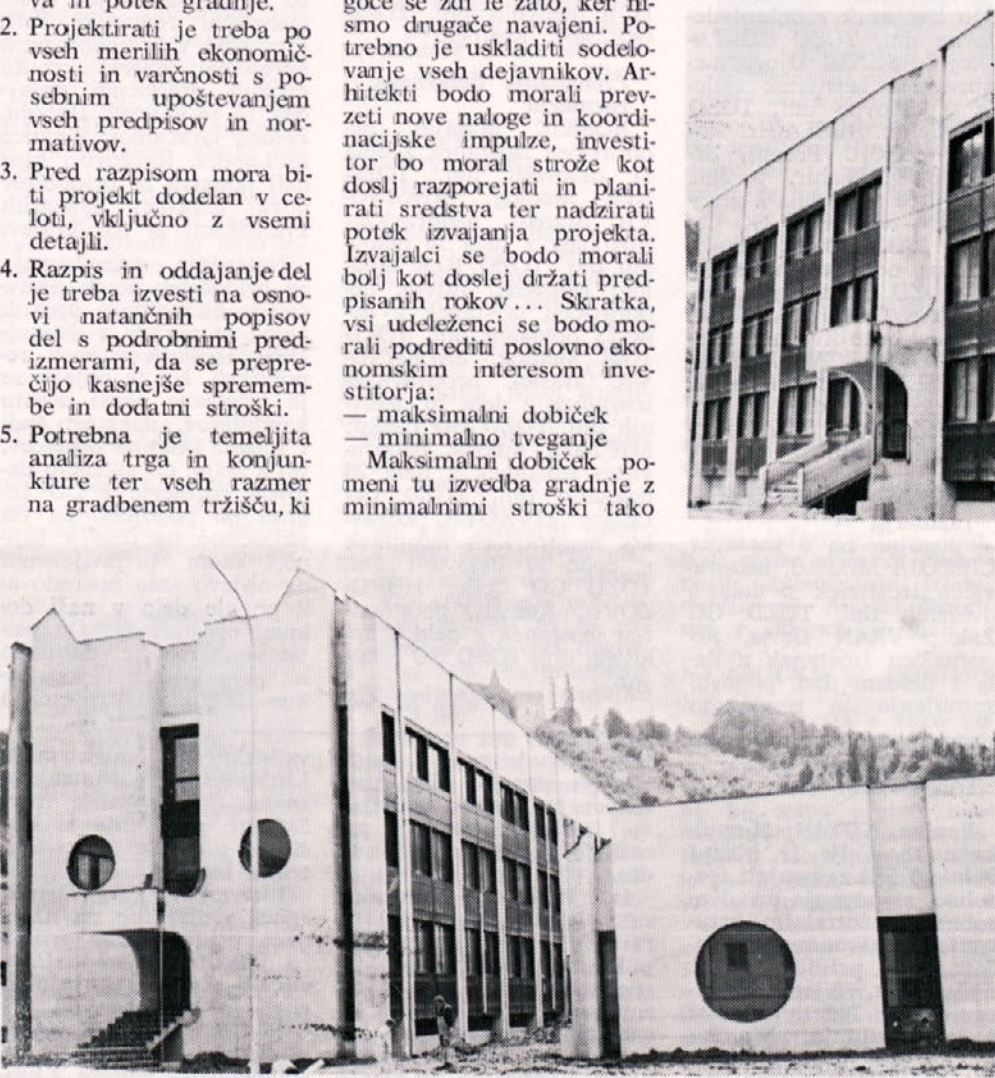
Gornja posnetka sta iz Šmarja pri Jelšah, z gradbišča občinske Upravne zgradbe
