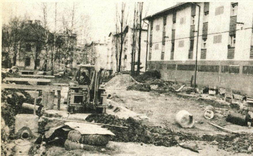
Gradbišče nove trgovine na Zlatem polju. - Foto: F. Perdan
