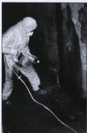
Dekontaminacija skladišča - fizično odstranjevanje kontaminiranih plasti na steni z vrtnikom.
