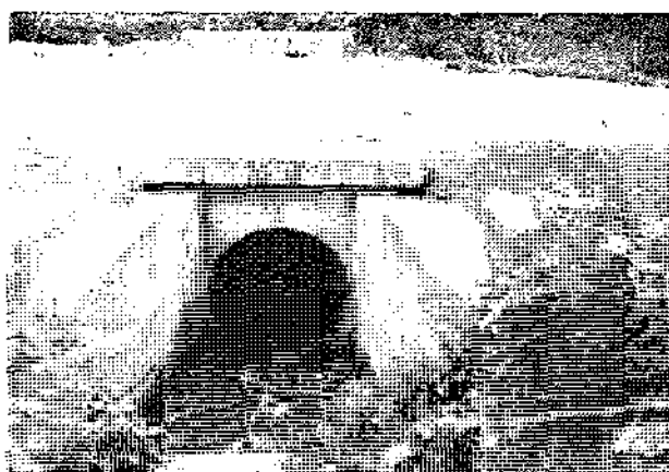
Cevni propust. Foto J. N.-M.
