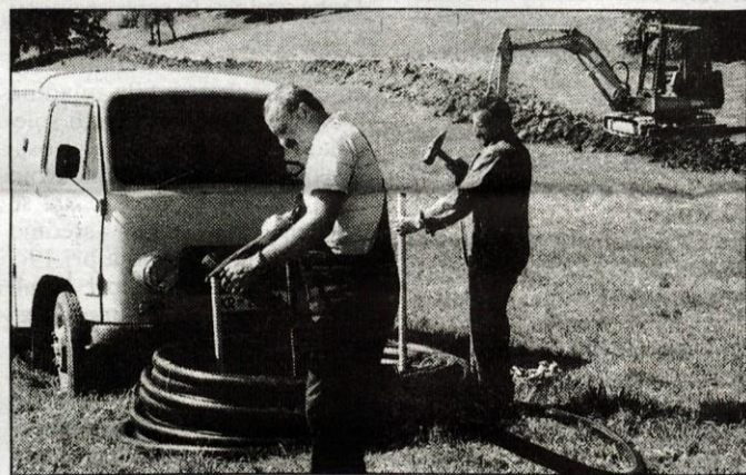
Delavci tržiškega komunalnega podjetja že gradijo vodovod Brdo - Hudo.
