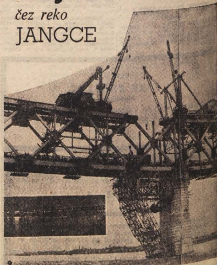
Na Kitajskem bodo kmalu dogradili orjaški most čez reko Jangce. Dolg bo 1155 m. Graditelji so v enajstih mesecih, boreč se s številnimi težavami, ki jim jih je povzročala reka, montirali 22.000 ton jeklenih konstrukcij, pri čemer so porabili 800.000 zakovic. Zdalj grade na gornjem delu mostu avtomobilsko cesto in poti za pešce in kolesarje. Na večji sliki vidimo montažo jeklenih konstrukcij, na manjši pa pogled na orjaški most ponoči
