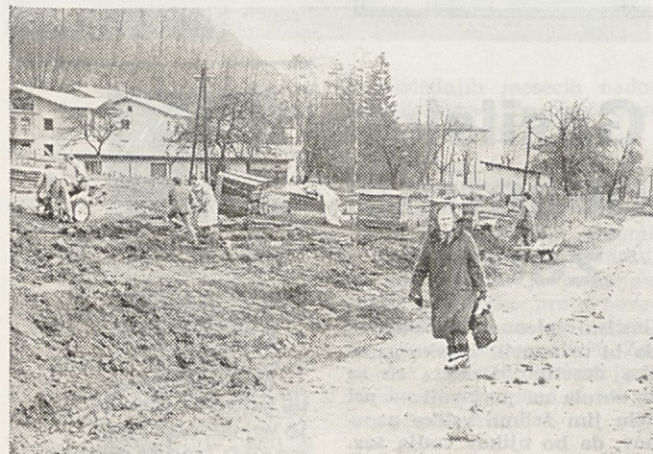
Pripravljalna dela za gradnjo nove hale so se pričela
