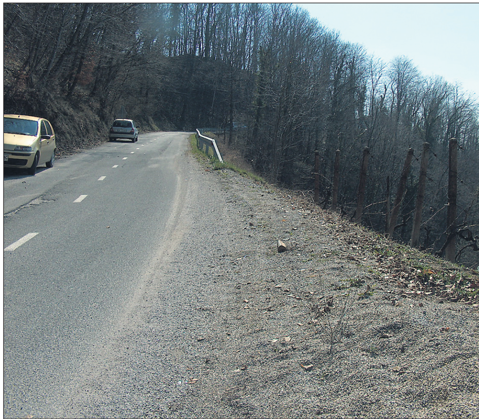
Na gorišniškem mejnem prehodu Meje še ni »zapela« lopata in nihče ne ve, kdaj bo. Na obnovo čaka tudi cesta proti prehodu (na sliki).
