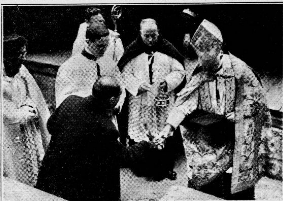
Predsednik Pokojninskega zavoda Vrtovec izroča nadškofu dr. Jegliču kladivo za simbolične udarce po temeljnem kamnu.
