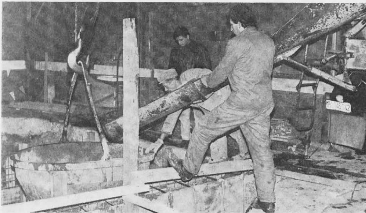
V Jeklovleku so januarja montirali nov luščilni stroj, ki ga je sofinancirala zahodnonemška firma Schmolz-Bickenbach, in ki si bo zato 10 let s tozdom delila ustrezen del dohodka. Stroj bo Jeklovleku omogočil za 4000 ton večjo letno proizvodnjo luščenega jekla (povečanje s sedanjih 2000 na 6000 ton). Domača naročila v letu 1986 zanj so, tuja pa še sklepajo.
