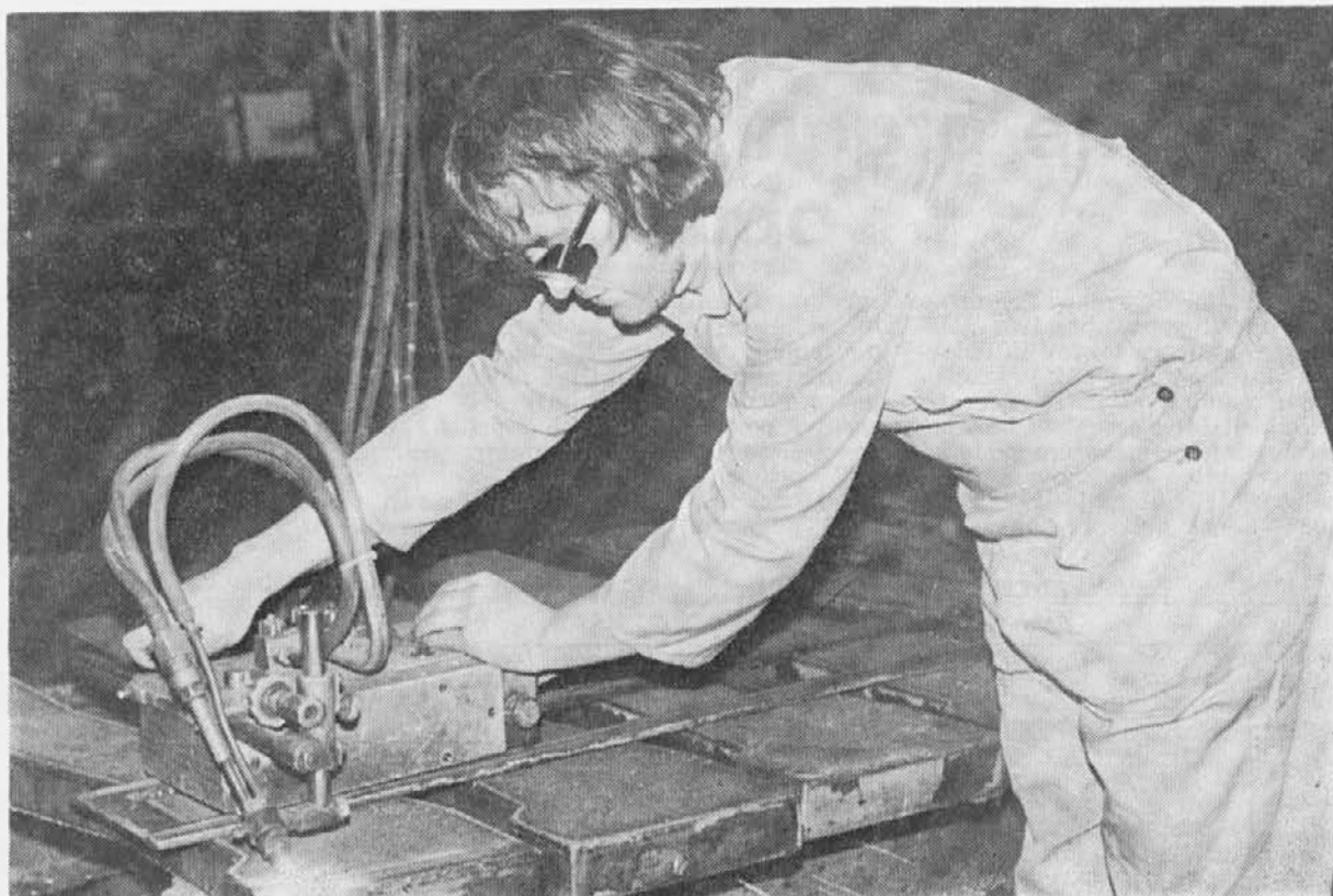
Rezanje na sekatorju v oddelku priprave proizvodnje
