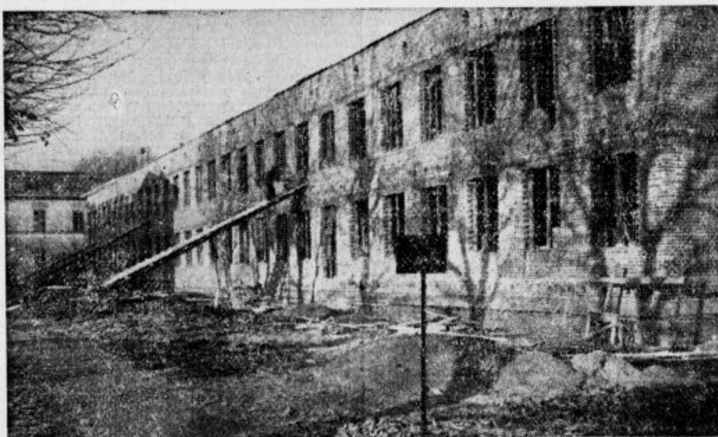
Pogled na novo zgrajeni prizidek kirurgičnega oddelka, v ozadju se naslanja na prizidek sedanji kirurgični oddelki, ki bo z novim prizidkom močno razbremenjen
