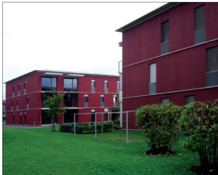
Untere Aue II in Untere Aue III, socialna stanovanjska gradnja v pasivnem standardu.
