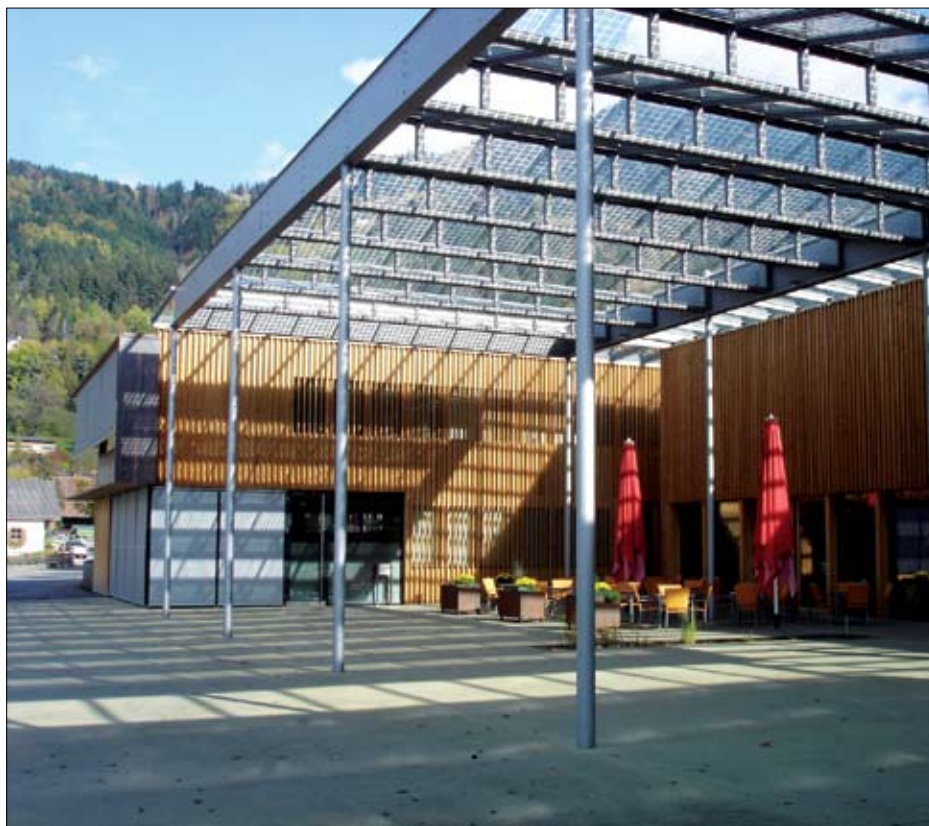
Novi občinski center v Ludeschu in prekriti trg s 350 m 2 veliko prosojno fotovoltaično napravo.
