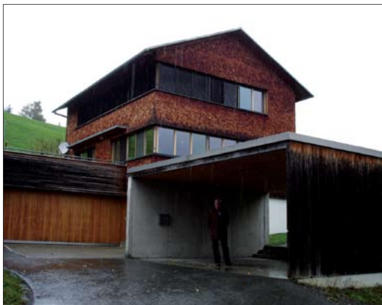
Schwarzenberg, primer značilne pasivne stanovanjske gradnje.
