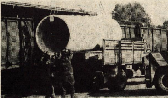
Kranj — Delavci SGP Gradbenec iz Kranja grade kanalizacijo za odpadno vodo tovarne Sava. Uporabljajo salonitne cevi iz Anhovega s premerom 120 cm. Transport tako velikih cevi je dokaj zahtevna naloga, zato so morali na tovarnjakih urediti posebne nosilce. (B. B.)
