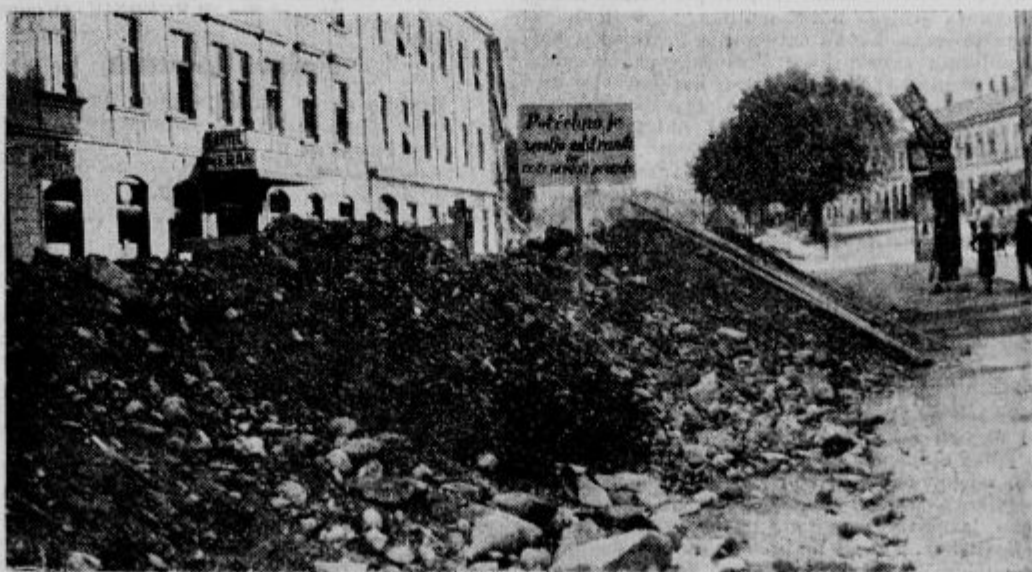
V Mariboru popravljajo Aleksandrovo cesto, ki je ena najlepših in najbolj prometnih. Na vrhu kupa gramoza in prsti je vsajena tablica z napisom: »Potrebno je zemljo odstraniti iz ceste predati promet«. Koipada je potrebno!
