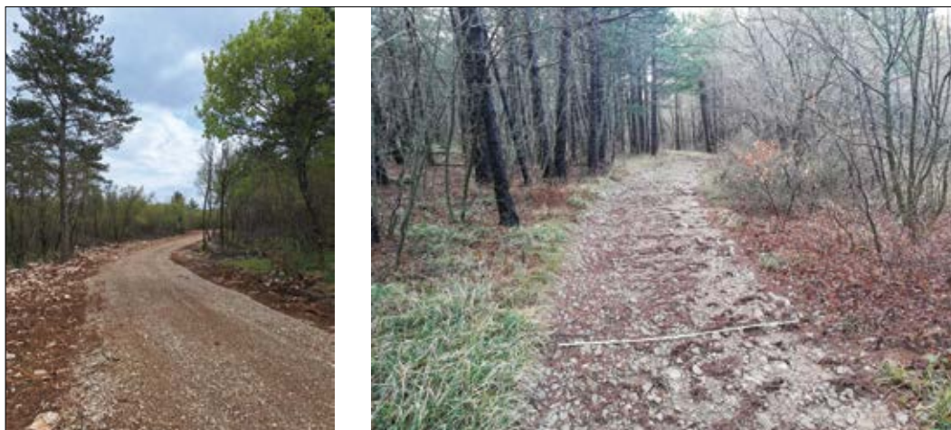
Slika 1: Protipožarna preseka I. kategorije (levo, A. Nève Repe) omogoča vožnjo vsem gasilskim vozilom, medtem ko je protipožarna preseka II. kategorije (desno, J. Saražin) namenjena le lahkim terenskim vozilom
