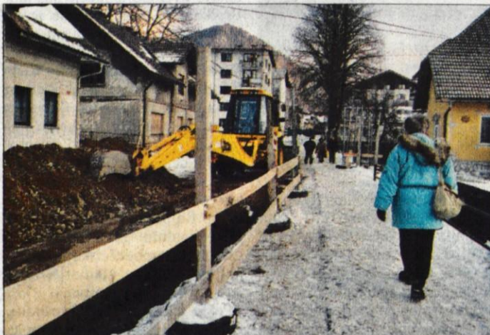
Primarni kolektor vkopujejo po sredi Ceste talcev.
