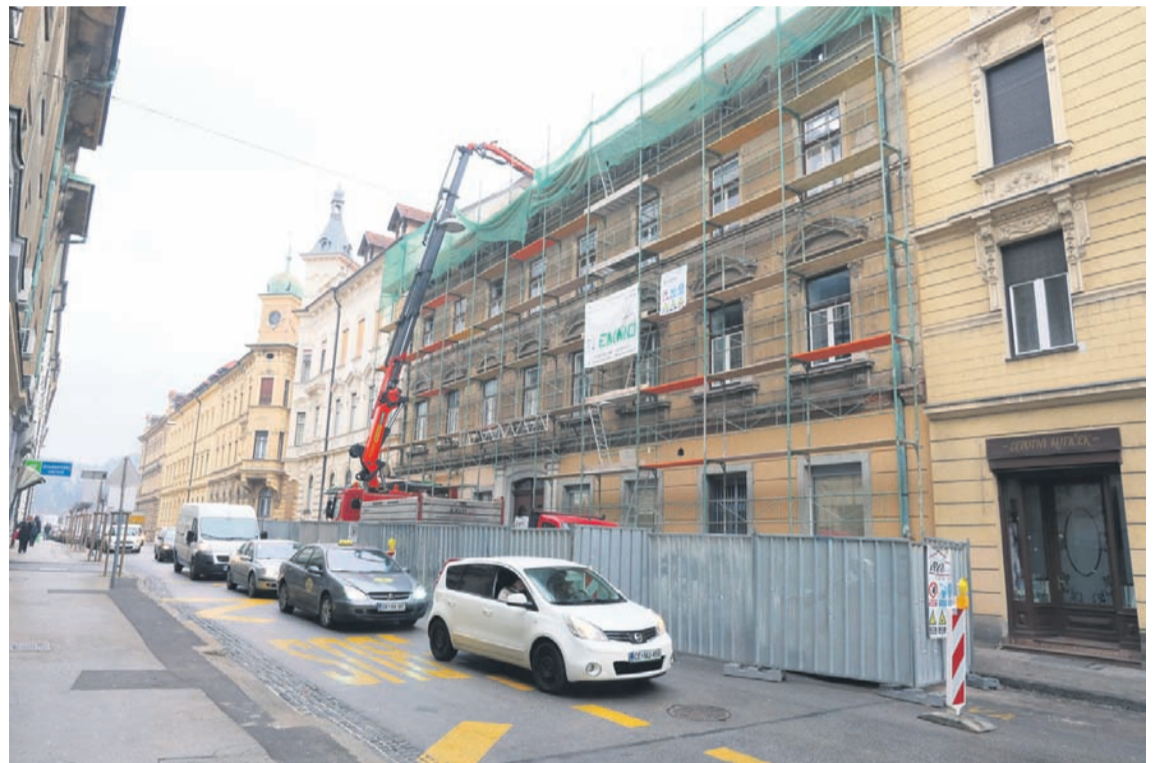
Obnova stavbe v Cankarjevi ulici 4 v Celju bo predvidoma končana sredi marca, česar se bodo ob stanovalcih, ki so jih morali preseliti, razveselili tudi vozniki in pešci, ki se gibajo na tej precej prometni ulici v mestnem jedru.
