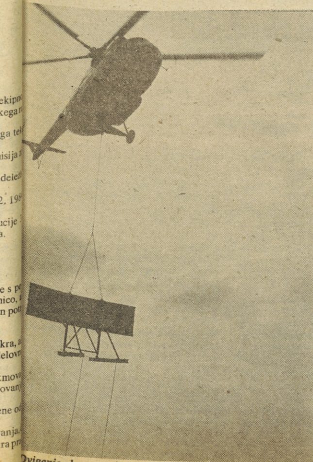
Dviganje ekrana semaforja.
